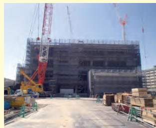
東面全景 (H28.3.22 撮影)
